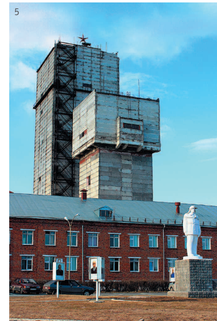
5. Шахта «Северопесчанская»: центральная группа стволов с копрами башенного типа.
