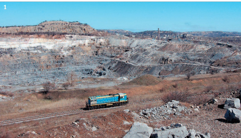
1. Западный известняковый карьер Новотроицкого рудоуправления, 2014 год. Фото: М.В. Кулишов.
